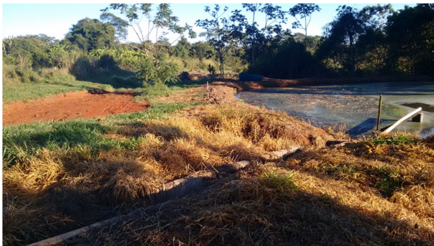
Figura 1 – Local de instalação dos sistemas alagados construídos.
